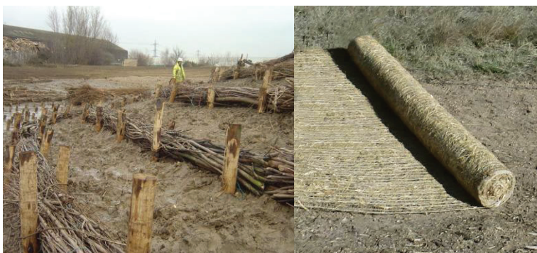
Figura 12. Fashina dhe shtresa antierozion me material të biodegradueshëm
