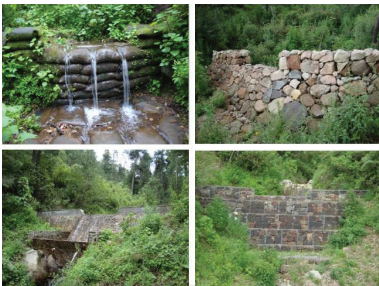
Figura 11. Prita malore me materiale të ndryshme për kontrollin e erozionit
